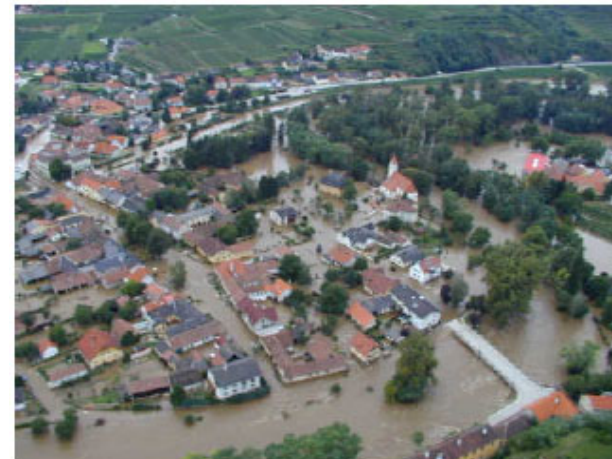
Abb. 6: Luftaufnahme von Zöbing während des Hochwassers 2002, Blick von Südosten
