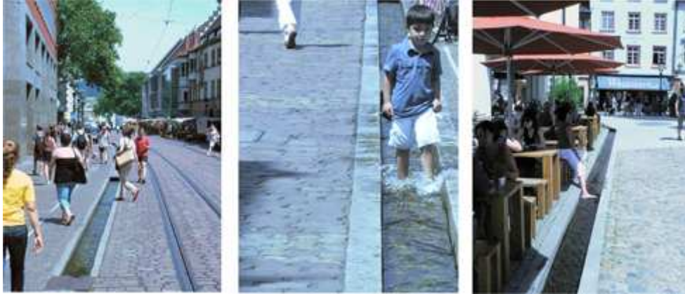
Abb. A_F- 13: Ableitung des Regenwassers in offenen Rinnen (Quelle: Tu Tech Innovation GmbH, 2011)
