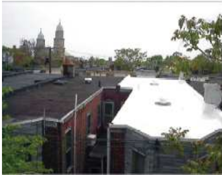
Abb. A_F- 9: Cool Roof auf einem Reihnhaus in Philadelphia (Quelle: Energy Coordinating Agency, Philadelphia, in: U.S. Environmental Protection Agency, 2008)
